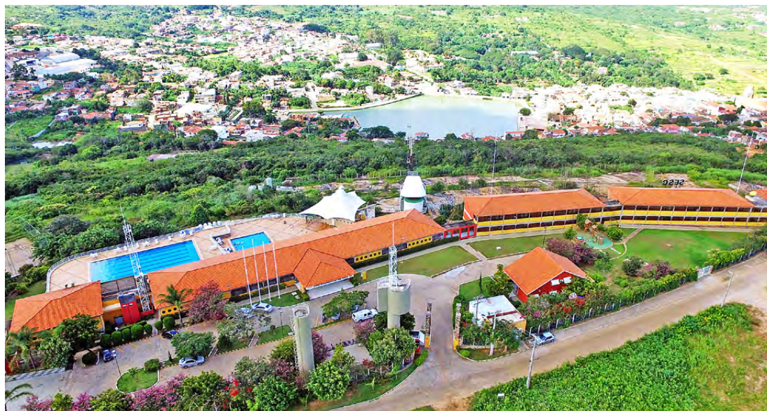
■ Estrutura do Hotel Sesc Triunfo vista de cima
