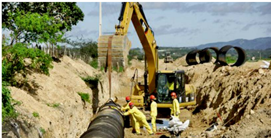
Adutora está com 60% das obras concluídas
