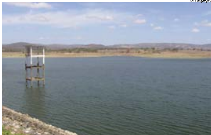
Após 25 meses em colapso, Barragem de Riacho do Pau armazena mais de 5% de sua capacidade e reduz o racionamento de água para Arcoverde
