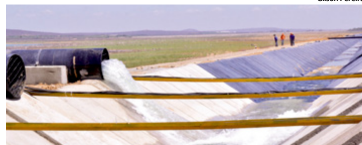
O canal levará água até a principal estação de bombeamento de Nilo Coelho e depois será bombeada com o uso da estrutura tradicional de captação
