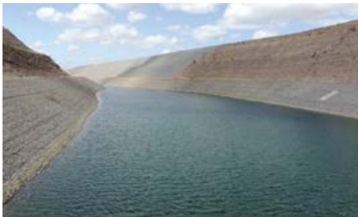
Comunidades rurais vão receber água da Transposição do São Francisco
