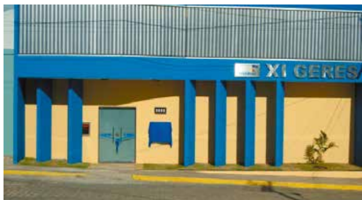
Fachada da XI Geres em Serra Talhada
